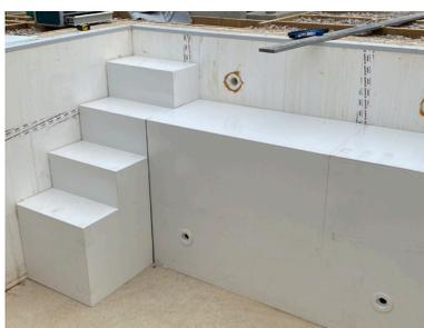
Direktes schweißen mittels wärmeaktivierbarem Kontaktkleber
