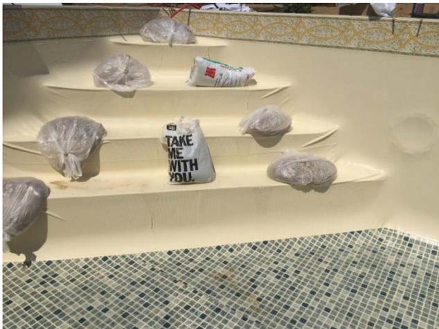
14. Fahren Sie so Stufe für Stufe fort, bis Sie oben angekommen sind. Hängen Sie dann die Folie beginnend an der Ecke der Treppe ein, fahren Sie dann jeweils über den Stufen fort und achten Sie darauf dass Sie die Folie gerade nach oben spannen und diese nicht seitlich verschieben. Fixieren Sie die Folie mit den Klammerhälften
